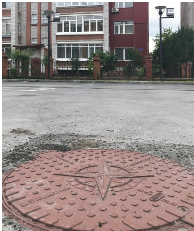
г. Тюмень ▲ Люк тип Л из высокопрочного чугуна с запорным устройством (Класс нагрузки С250)
