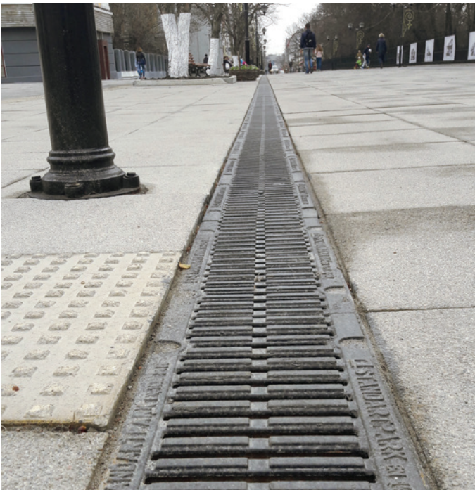
Масловский взвоз, г. Тюмень Линейный водоотвод. Серия Basic (Класс нагрузки A15)
