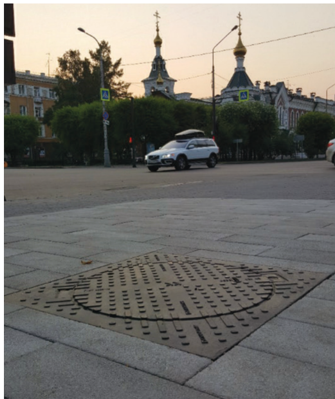
Реконструкция проспекта Мира и ул. Дзержинского, г. Красноярск ▲ Люк тип Т из высокопрочного чугуна в квадратном корпусе с запорным устройством (Класс нагрузки С250)
