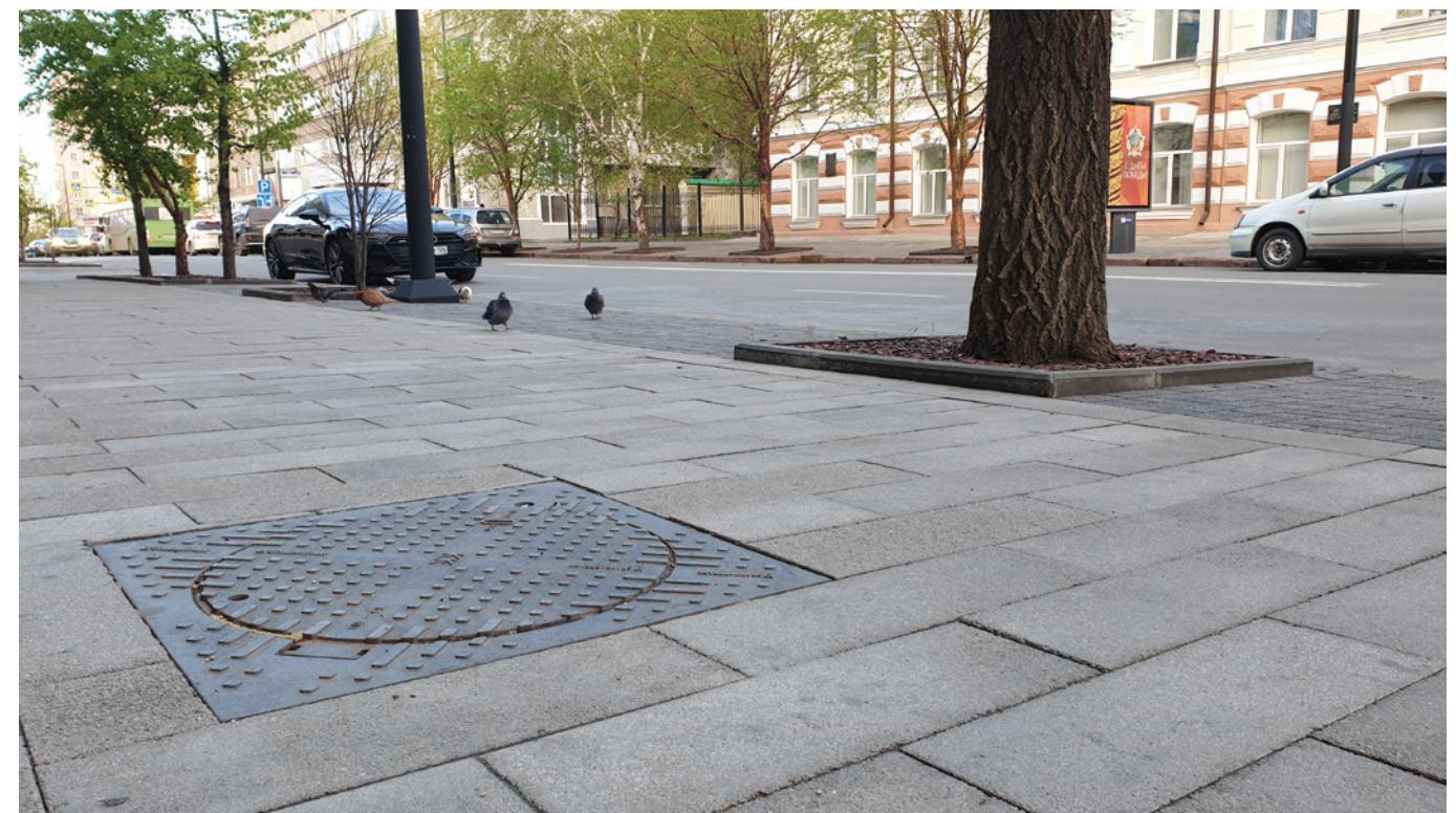
▲ Территория вокруг института физической культуры ТГУ, г. Тюмень Люк тип Л из высокопрочного чугуна с запорным устройством (Класс нагрузки С250)
