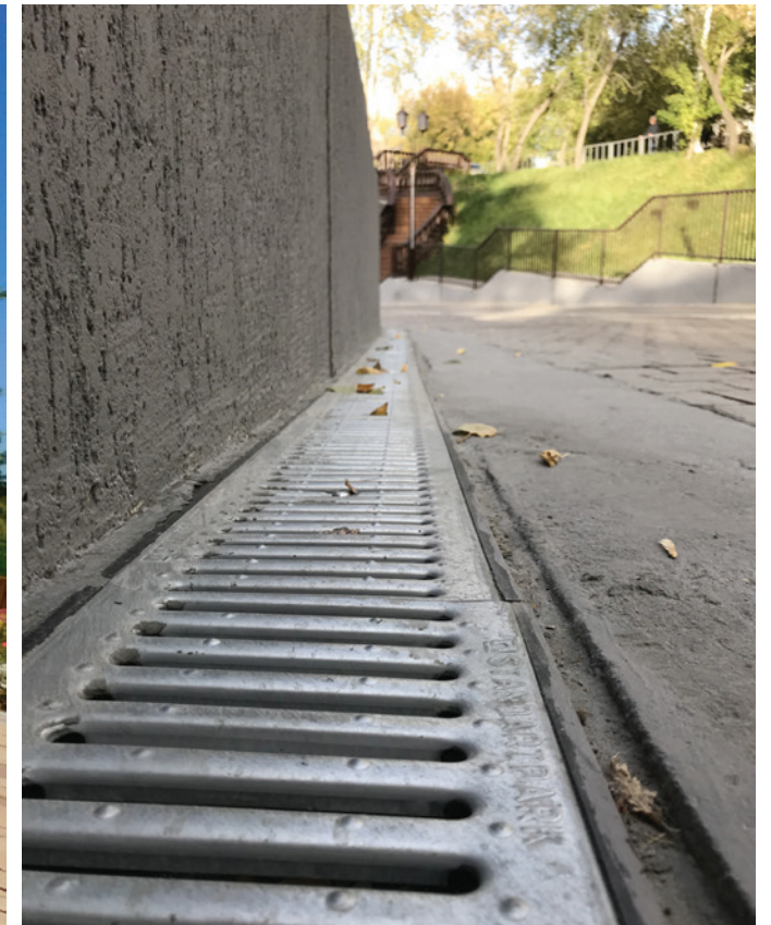
▲ Ул. Масловский взвоз, г. Тюмень Линейный водоотвод. Серия Basic (Класс нагрузки A15)
