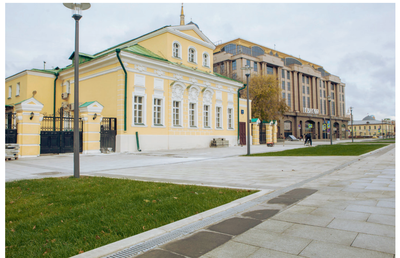
Смоленская площадь, г. Москва Линейный водоотвод. Серия Drive (Класс нагрузки D400)
