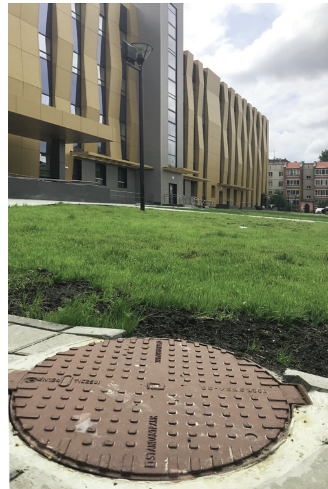
▲ Территория вокруг института физической культуры ТГУ, г. Тюмень Люк тип Л из высокопрочного чугуна с запорным устройством (Класс нагрузки С250)
