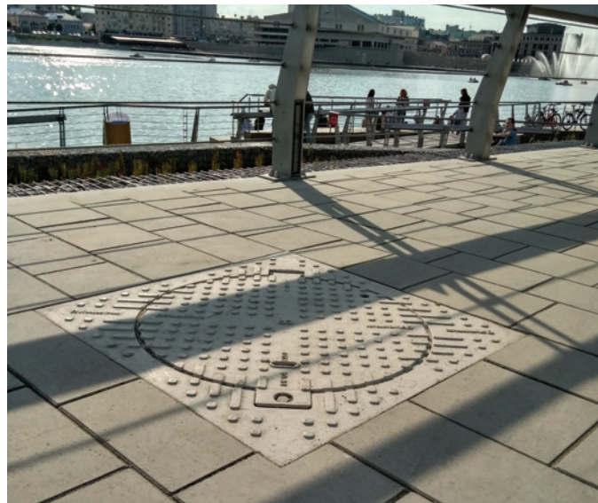
▲ Благоустройство набережной оз. Нижний Кабан, г. Казань Люк тип Т из высокопрочного чугуна в квадратном корпусе с запорным устройством (Класс нагрузки С250)
